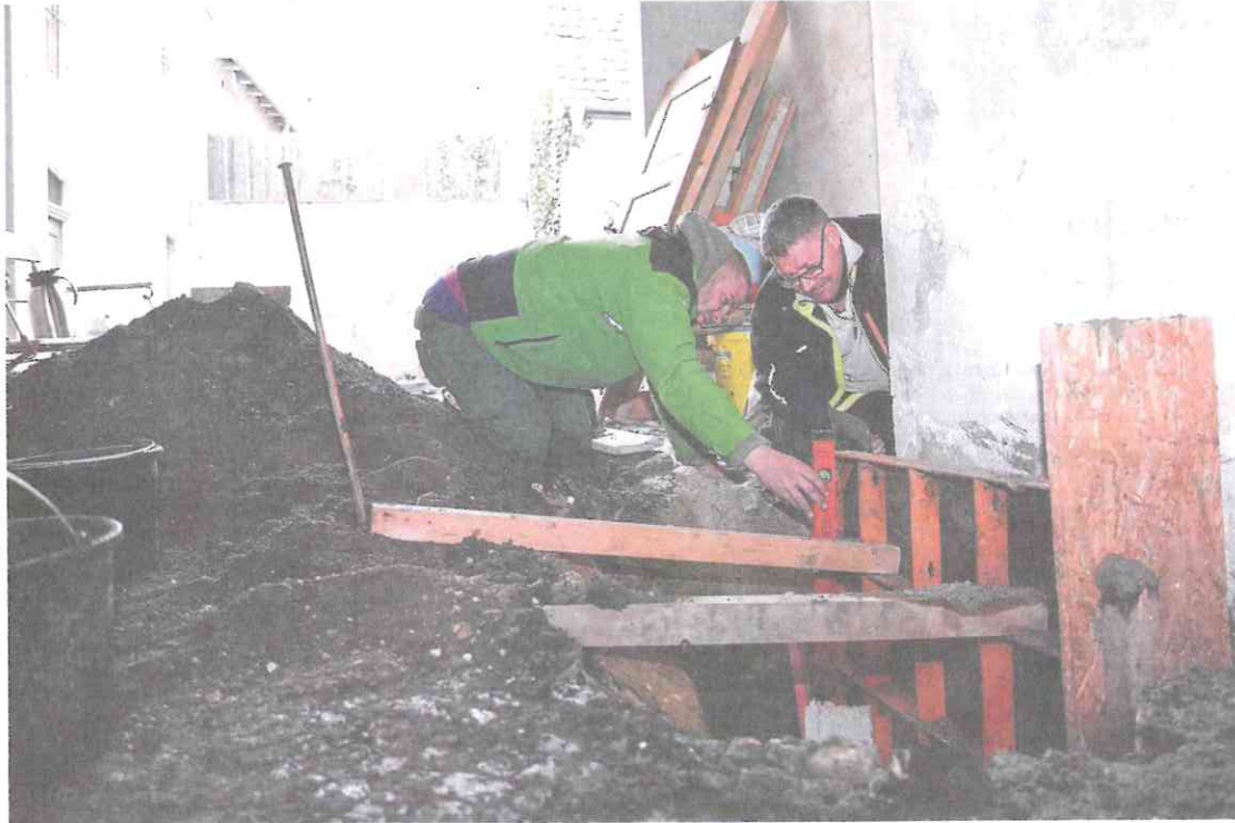
Während das Museumsteam Veranstaltungen für 2021 plant, gehen die Bauarbeiten an der Synagoge voran. Die Mitarbeiter der Firma Heilemann Tief- und Straßenbau Christopher Petersohn (links) und Dirk Becker waren am Donnerstag mit der Fundamentsunterfangung im Torhaus beschäftigt. FOTO: UTE NICKLISCH
