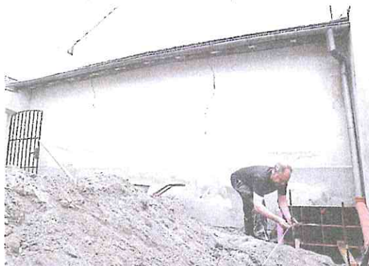
Die Risse in der Fassade der Synagoge Gröbzig zeigen, dass hier unglaubliche Kräfte auf das Fundament wirken, das stabilisiert werden muss. FOTO: UTE NICKLISCH
